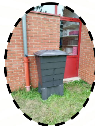
Récupérateur d'eau pluviale à l'école élémentaire
